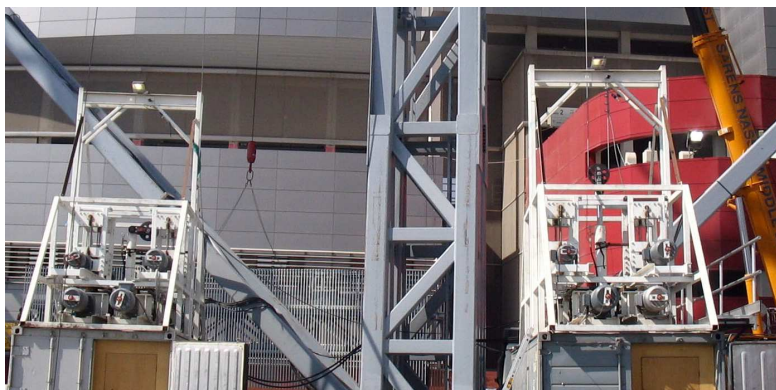
Φωτ. 8-9 Τα καλώδια ανάρτησης και μεταφοράς με τα βαγονέτα και τους υδραυλικούς κυλίνδρους
