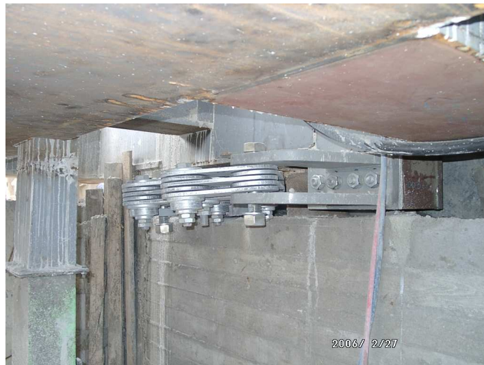
Φωτ. 8 Εγκατάσταση αποσβεστήρα
