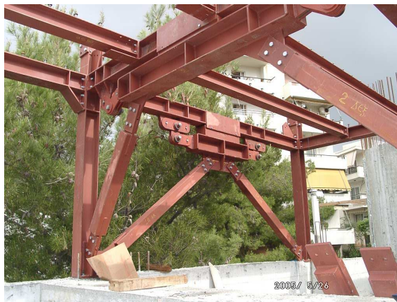
Φωτ. 3 Ανέγερση μεταλλικής κατασκευής και αποσβεστήρων
