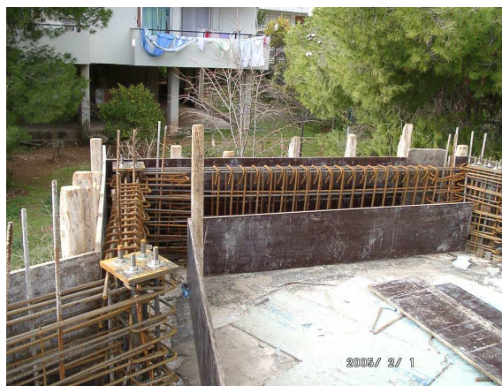
Φωτ. 2 Κατασκευή στηθαίου και αγκύρωση μεταλλικών υποστυλωμάτων
