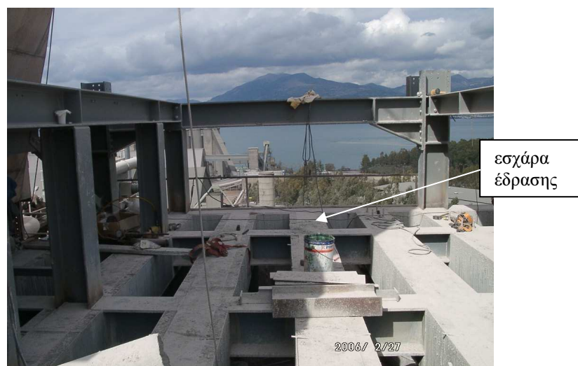
Φωτ. 7 Ανέγερση μεταλλικού φορέα
