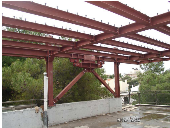
Φωτ. 4 Ανέγερση μεταλλικής κατασκευής και αποσβεστήρων
