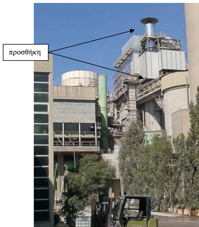
Φωτ. 5 Εγκατάσταση αποκονίωσης στην οροφή υφισταμένου σιλό
