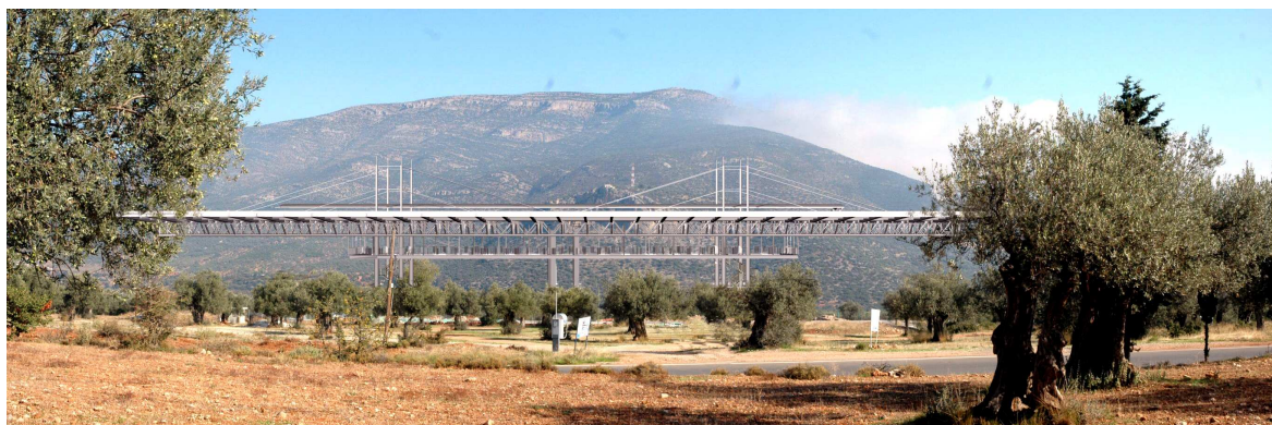
Φωτ. 1 Όψη του στεγάστρου
