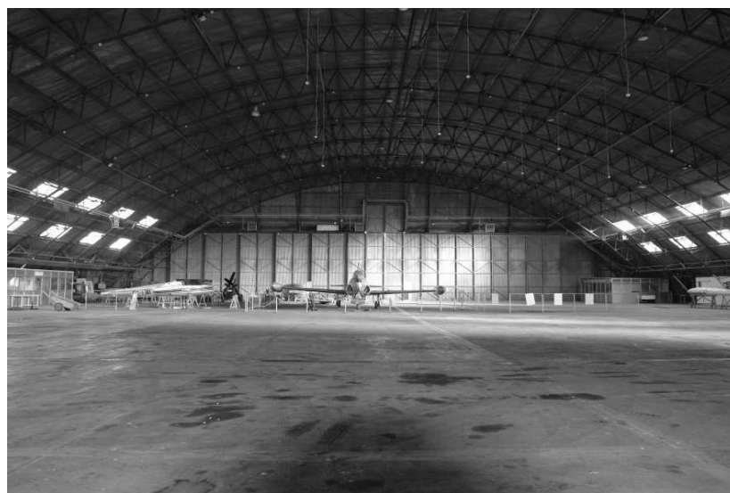
Φωτ. 3 Εσωτερική όψη του ΧΥ
