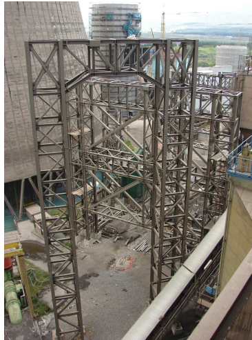
Φωτ. 2 Ανέγερση πυλώνων στήριξης αγωγών
