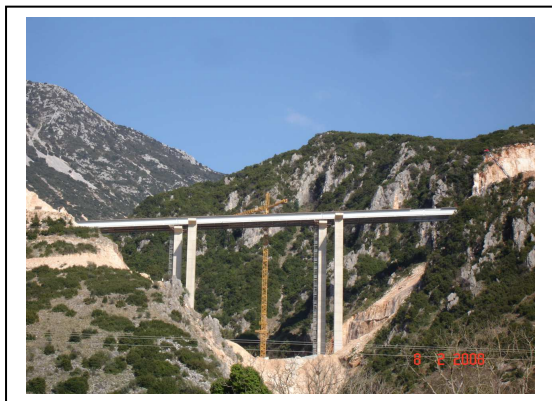
Φωτ. 1 Όψη της Γέφυρας
