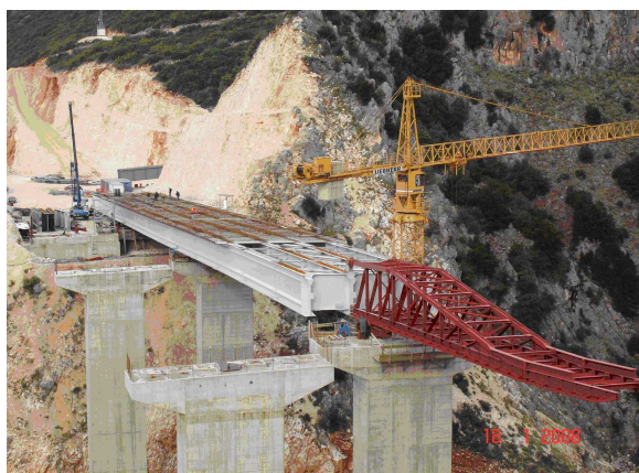
Φωτ. 5 Όψη Ρύγχους και Μεταλλικών Δοκαριών
