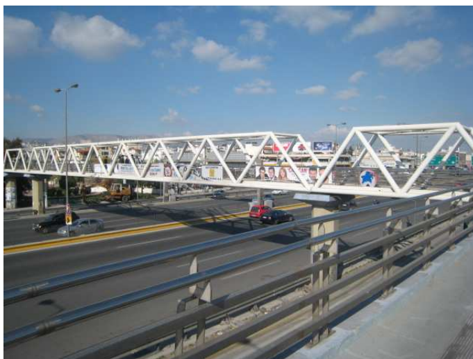
Σχήμα 1: Μεταλλική πεζογέφυρα Εθνικής οδού Αθηνών-Λαμίας.
