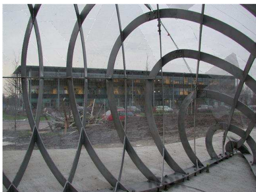
Φωτ. 13 Αποψη του εσωτερικού. Διακρίνεται ο μεταλλικός φορέας
