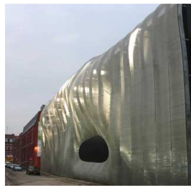
Φωτ. 12 Άποψη του εξωτερικού τη μέρα. Διακρίνονται οι μεταλλικοί στατικοί φορείς πίσω από την ημιδιαφανή επιδερμίδα.
