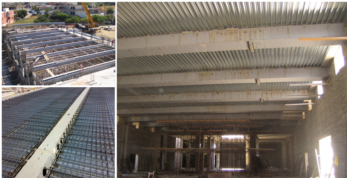
Σχ. 7: Έδραση δοκών χαλυβδοφύλλων – σκυροδέτηση – αφαίρεση ικριωμάτων
