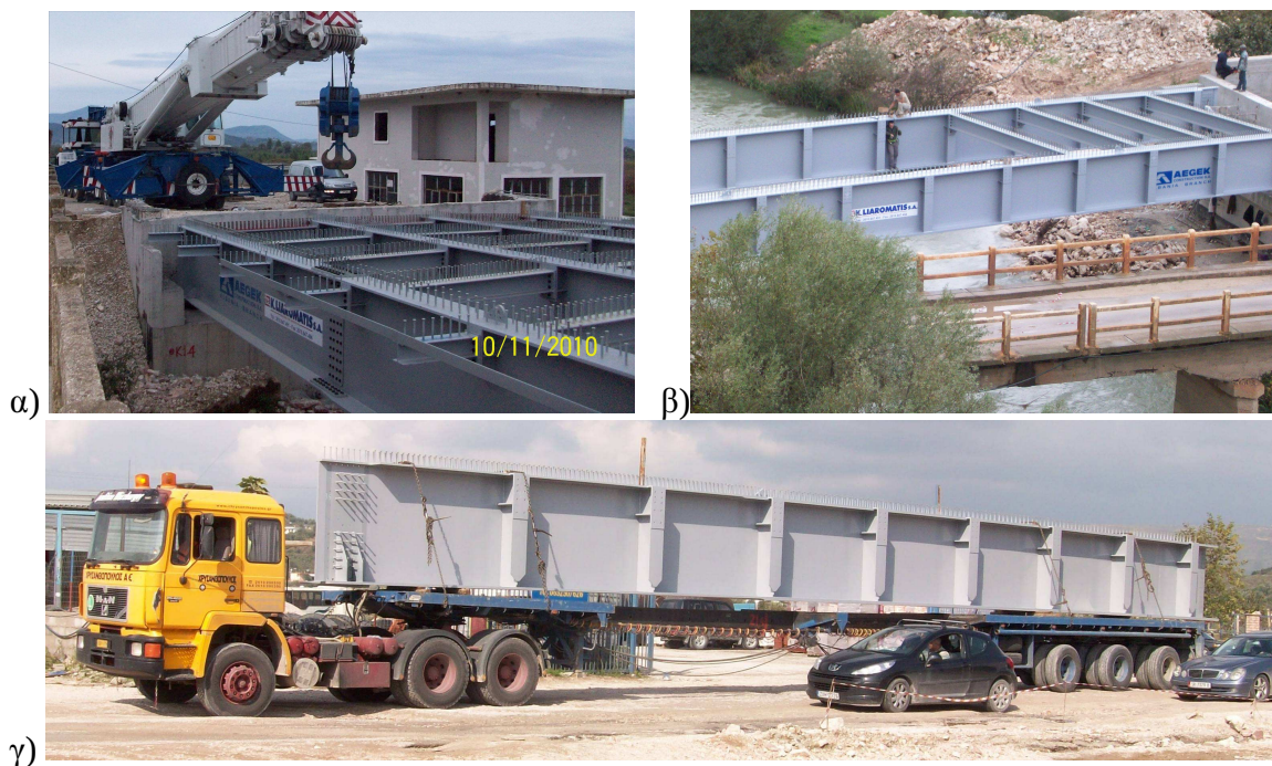
Φωτ. 1: Κατασκευή γεφυρών: (α) Γ2, (β) Γ4, (γ) Γ3
