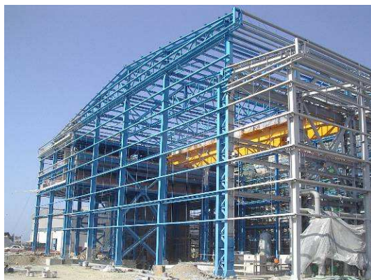
Φωτ. 2 Κτήριο ατμοστροβίλου Μονάδας 4
