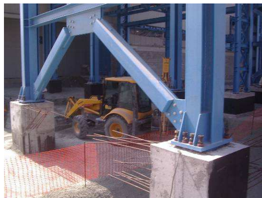
Φωτ. 6 Σύνδεση διαγωνίων στοιχείων συνδέσμων δυσκαμψίας
