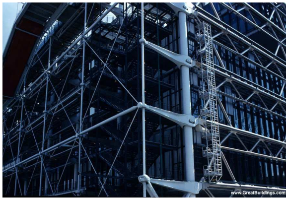
Εικόνα 4 : Ειδικά χυτοχάλυβδινα στοιχεία σε έργα υψηλής τεχνολογίας
