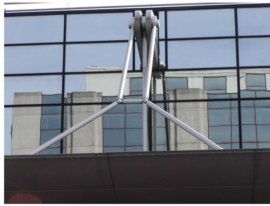
Εικόνα 3: Ειδικά μεταλλικά στοιχεία (ελκυστήρες, αρθρώσεις, πείροι)
