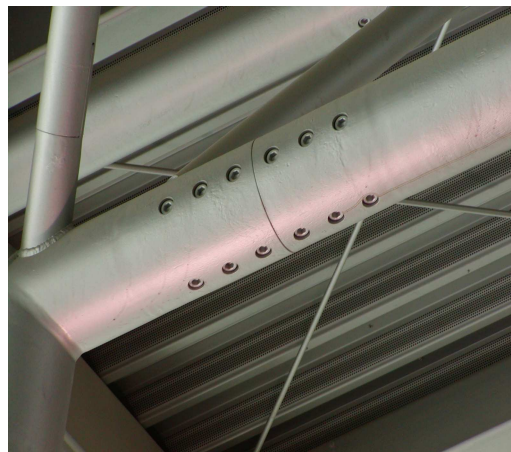
Εικόνα 6: Κοχλίες βυθισμένης κεφαλής
