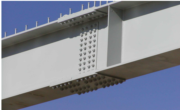
Εικόνα 8 : Καθολική κοχλιωτή σύνδεση επιτόπου
