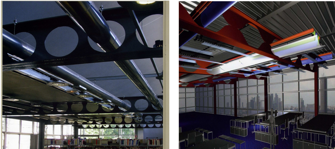
Εικόνα 9: Δοκοί με ανοίγματα κορμού
