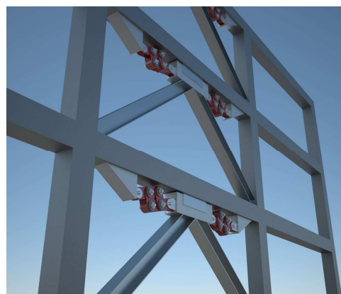
Εικ. 2: Διάταξη αντιανεμίων (όψη από την κάτω πλευρά του φορέα) και απεικόνιση διάταξης αποσβεστήρων (εικόνα αποσβεστήρων © Damptech)
