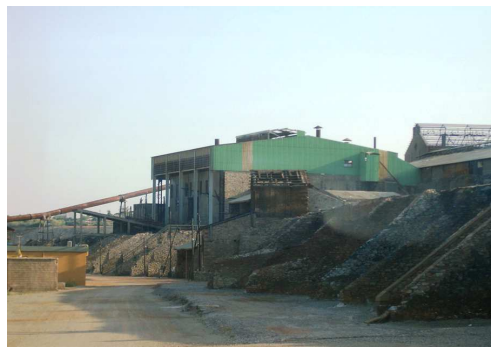
Φωτ. 1-Το κτίριο της Φρύξης, βορειοανατολική άποψη (Μάρτιος 2008)
