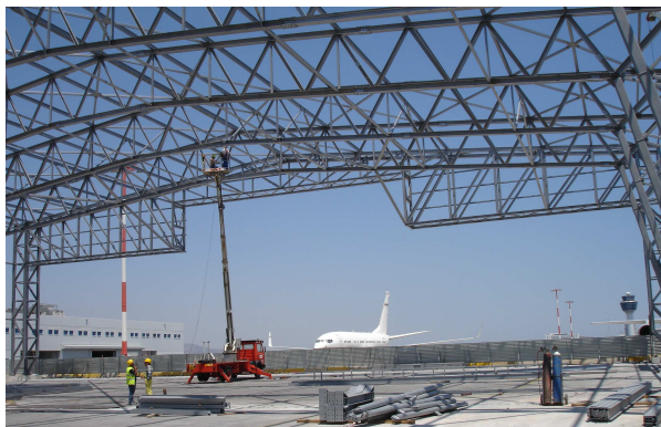
Εικ.7 Τμήμα του φορέα κατά την κατασκευή
