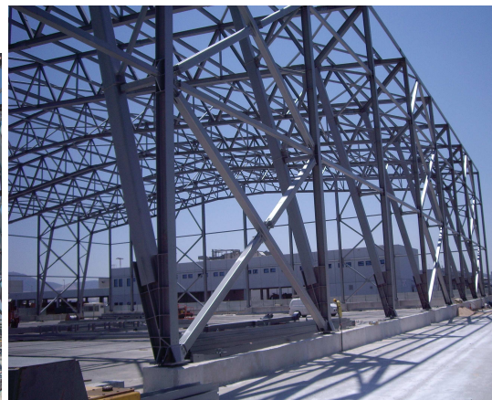
Εικ.8 Τμήμα του φορέα κατά την κατασκευή
