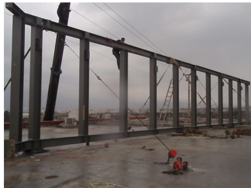
Εικ. 11 Συναρμολόγηση τμημάτων οροφοδοκού β)
