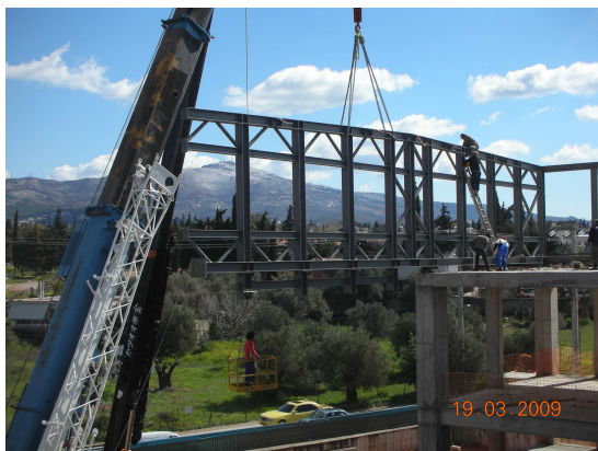
Εικ. 12 Ανέγερση οροφοδοκού γ)
