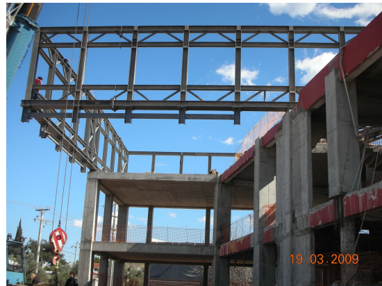
Εικ. 13 Σύνδεση οροφοδοκών β) και γ)
