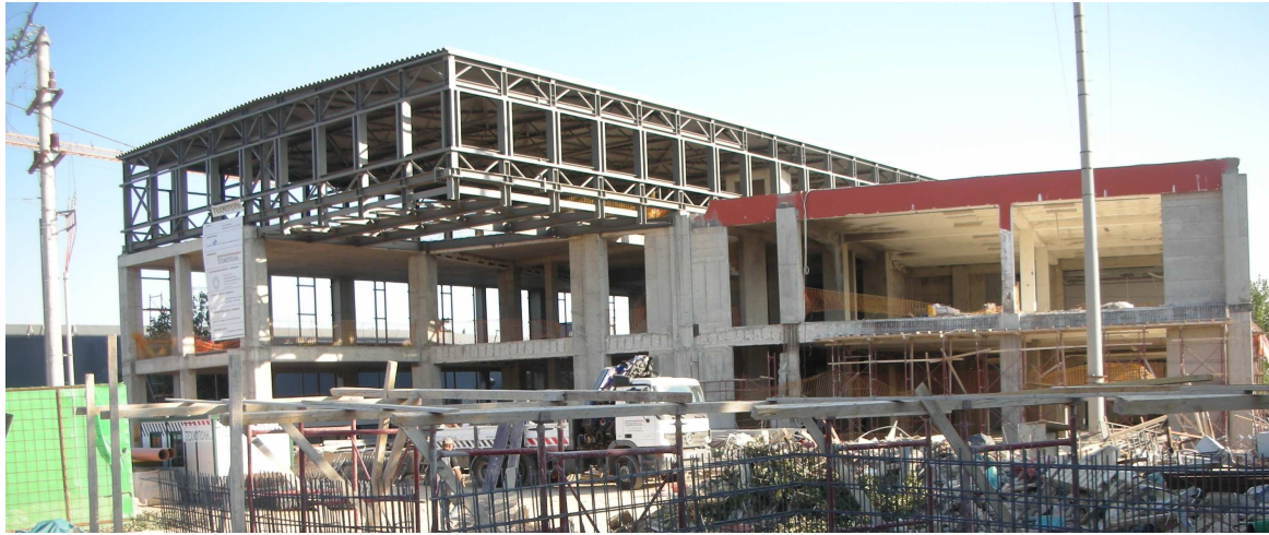
Εικ. 16 Συνολική άποψη φέρουσας κατασκευής και επικάλυψης
