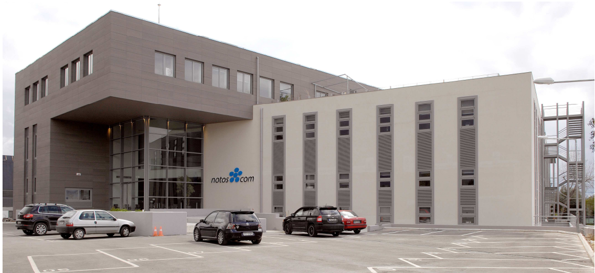
Εικ. 17 Άποψη ολοκληρωμένης κατασκευής
