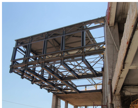
Εικ. 15 Περιοχή προβόλου με μερική επικάλυψη στέγης και φορείς του εν προβόλω δαπέδου
