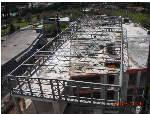
Εικ. 14 Σύστημα οροφοδοκών και δικτυωμάτων στέγης
