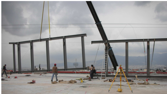
Εικ. 10 Ανέγερση τμήματος οροφοδοκού β)
