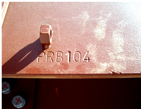
Φωτ. 1 Η ετικέτα αναγράφεται σε κάθε στοιχείο της κατασκευής
