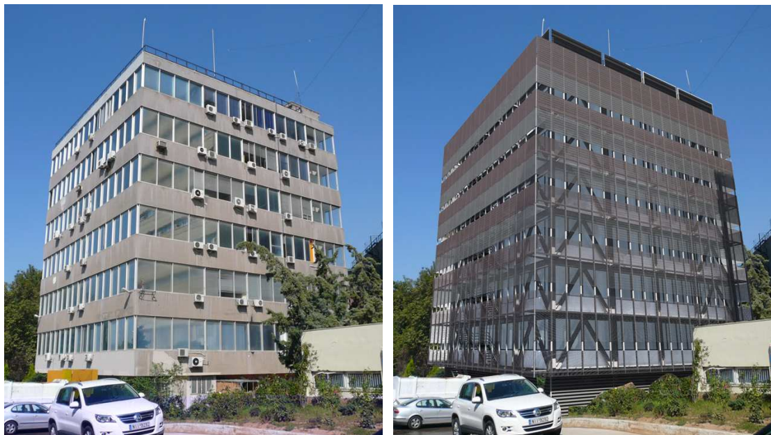
Σχ. 5: Υφιστάμενο και ενισχυμένο κτίριο (φωτορεαλιστική απεικόνιση).
