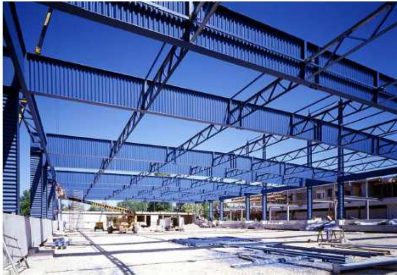
Φωτ. 1.1 – Βιομηχανικό κτήριο με διατομές μορφής I_{κυμ}
