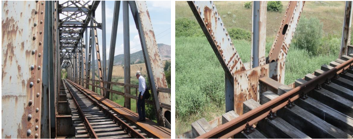
Εικόνα 1. Αποψη α) του καταστρώματος β) τυπικού κόμβου της παλαιάς δικτυωτής σιδηροδρομικής γέφυρας
