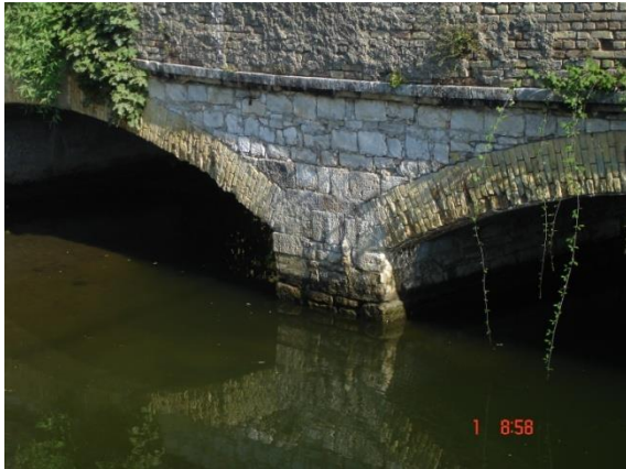
Φωτ 5: Η τοξωτή γέφυρα, το μεσοβάθρο.
