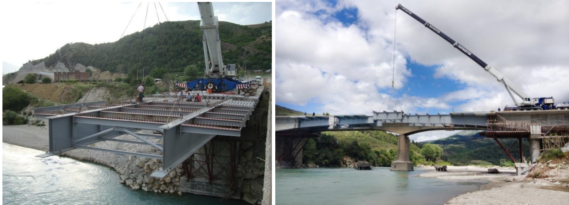
Σχ.6: Τοποθέτηση του δεύτερου και του τρίτου σπονδύλου (κλείδα) και αποκατάσταση συνέχειας καταστρώματος
