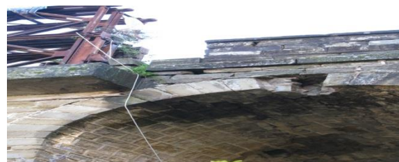
Φωτ. 4 Βλάβη κλείδας ακροβάθρου
