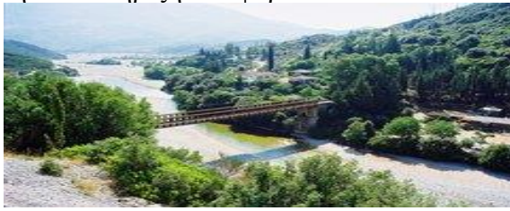
Φωτ. 1 Η Γέφυρα Μπανιά μέχρι το 1986
