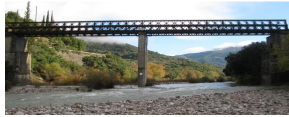
Φωτ. 2 Η γέφυρα Μπανιά με το μεσόβαθρο
