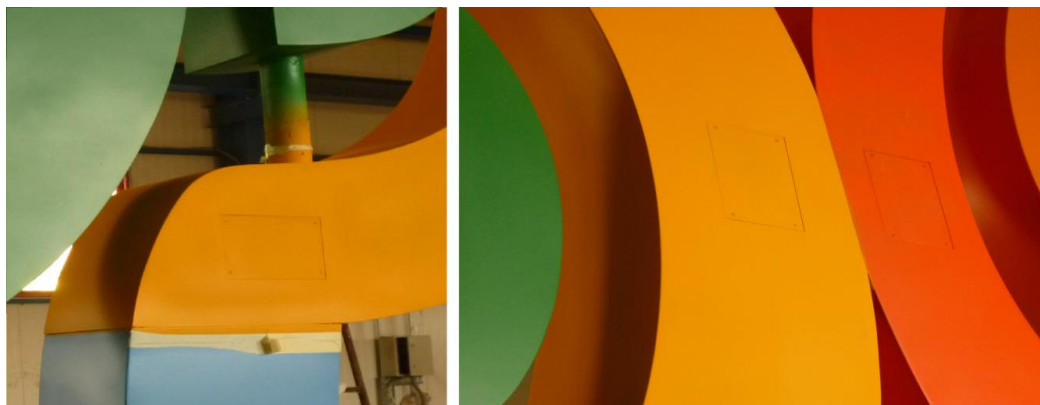
Φωτ. 9 Θυρίδες πρόσβασης για την κοχλίωση στις αποκαταστάσεις συνέχειας και κάλυψή τους.
