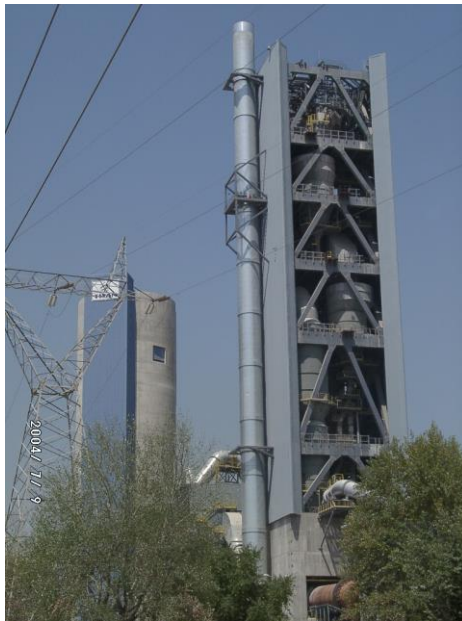
Εικ. 1 Καμινάδα ύψους 130 μ στηριζόμενη επί παρακείμενου φορέα.
