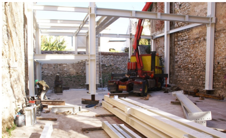
Φωτ. 3: Τοποθέτηση των υποστυλωμάτων σε χαλύβδινα υποθέματα
