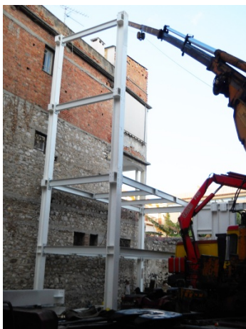
Φωτ. 2: Έναρξη κατασκευής από μια γωνία του κτηρίου
