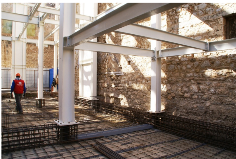
Φωτ. 4: Τοποθέτηση οπλισμού πλάκας θεμελίωσης και συνδετήριων δοκών.
