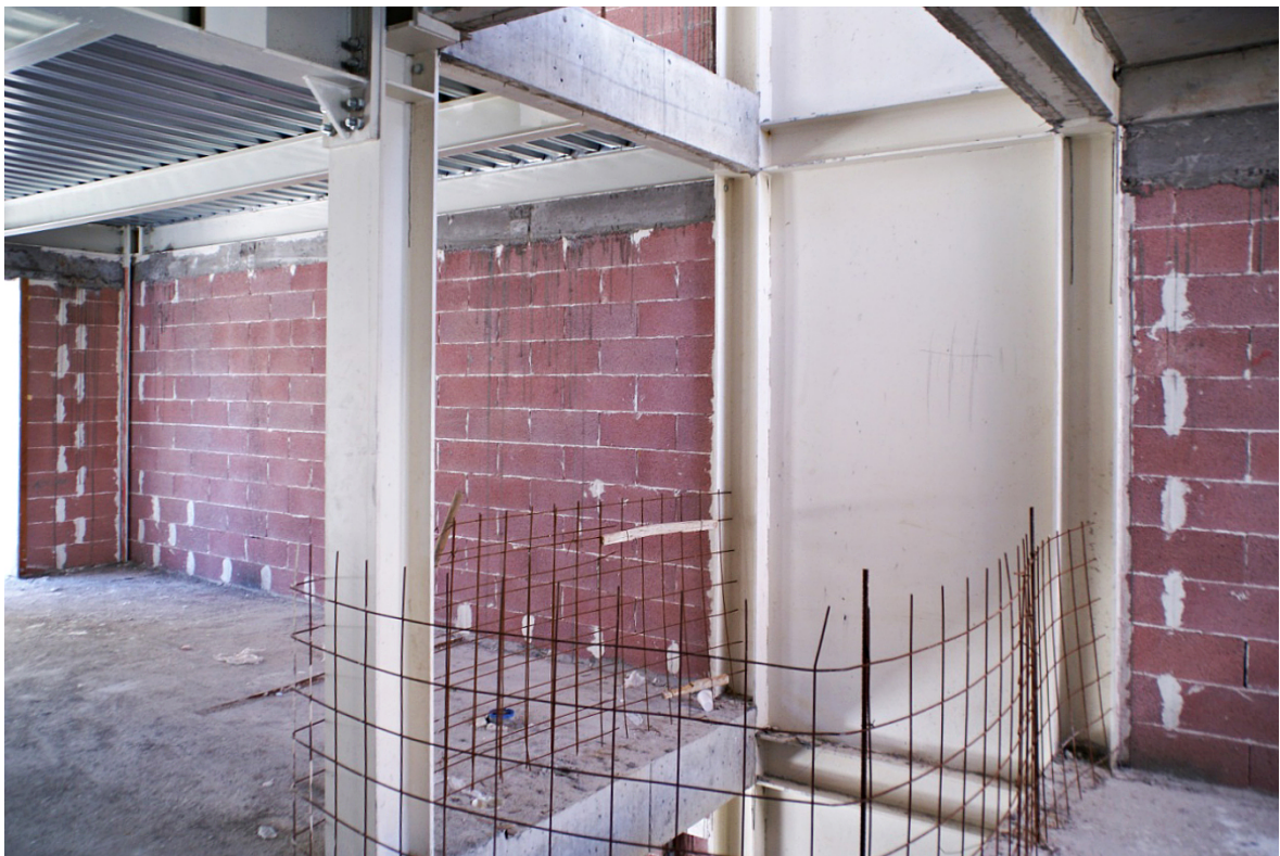
Φωτ.6: Τοίχοι πλήρωσης από κισσηρόλιθο με σενάζ στη θέση του σφηνώματος (Φάση 2).
