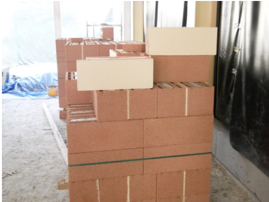
Φωτ.7.: Προεπιχρισμένοι κισσηρόλιθοι
