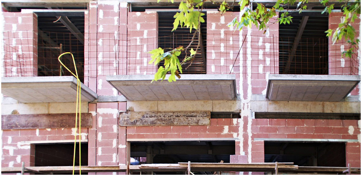
Φωτ.5: Τοίχοι πλήρωσης από κισσηρόλιθο με «φωλιές» για την κατασκευή σενάζ στη θέση του σφηνώματος (Φάση 1).
