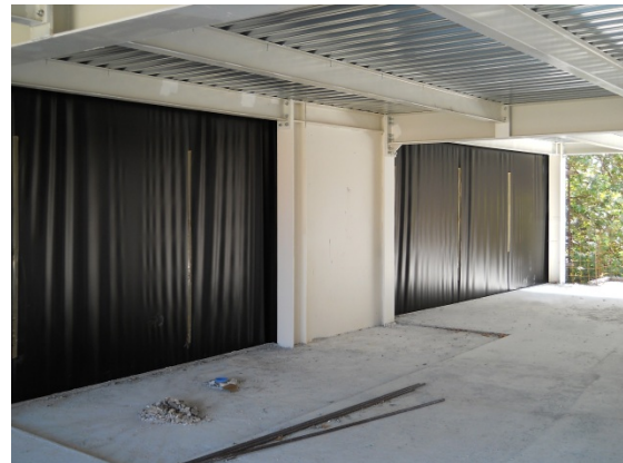
Φωτ.8.: Κουρτίνα πολυαιθυλενίου πριν την κατασκευή της τοιχοποιίας
