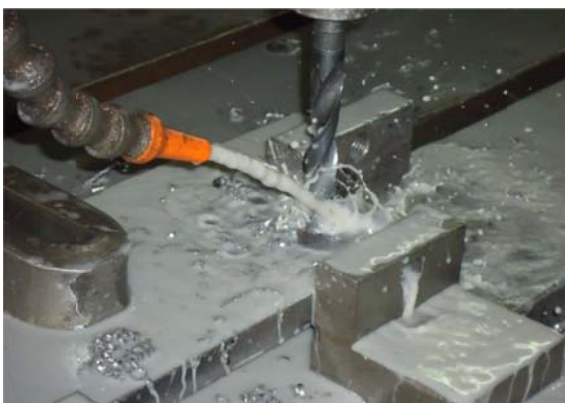
Φωτ. 6: Διάνοιξης οπών στη λεπίδα του υποστυλώματος.
