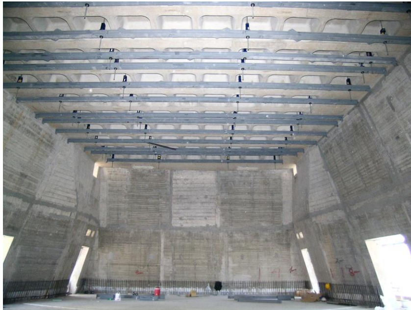
Εικ.8 Ανάρτηση δοκών οροφής
