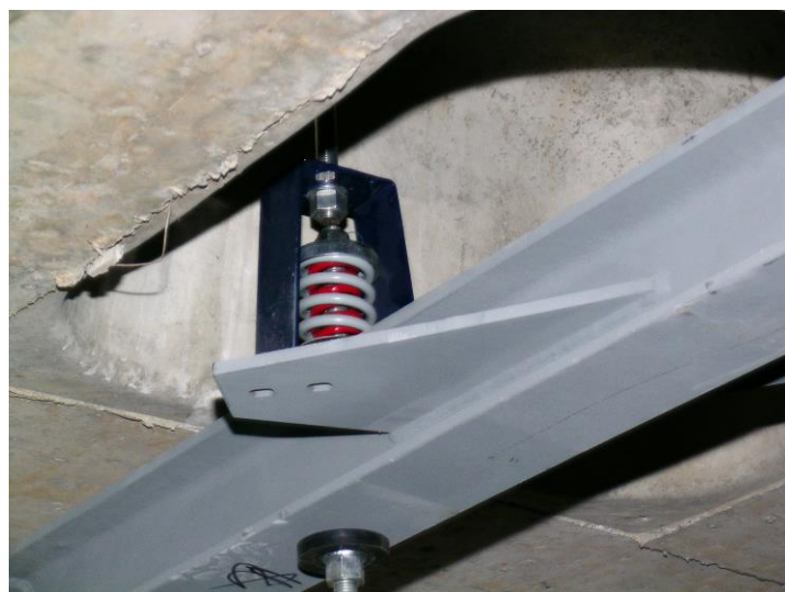
Εικ.9 Λεπτομέρεια ελατηρίου ανάρτησης δοκών οροφής
