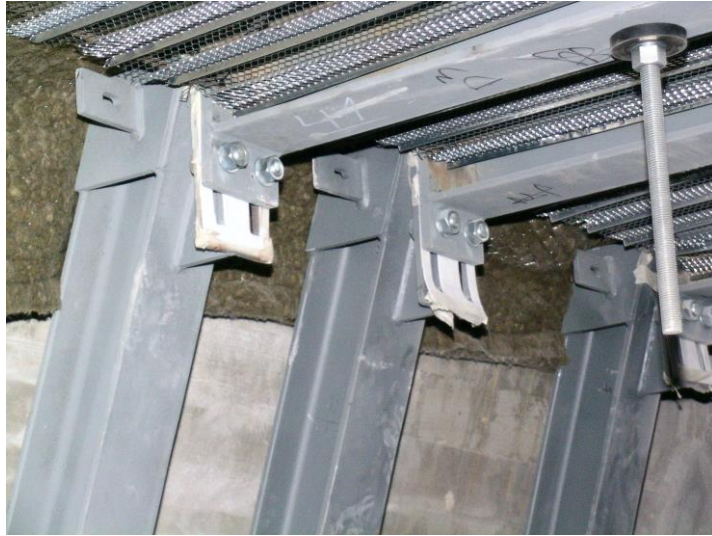
Εικ.10 Λεπτομέρεια σύνδεσης δοκών οροφής-υποστυλωμάτων
