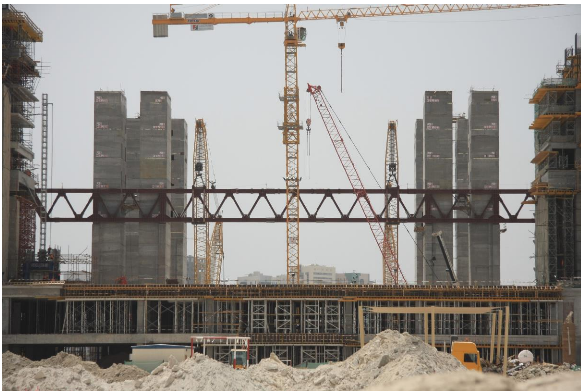
Φωτ. 2: Εξωτερικό υπερ-δικτύωμα επί των δίδυμων πυρήνων οπλ. σκυρ/τος
