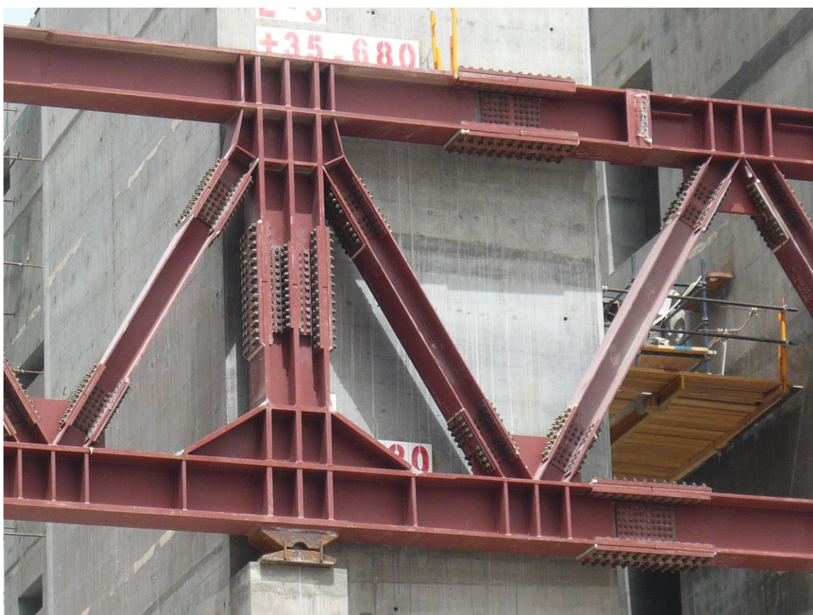
Φωτ. 3: Εδραση υπερ-δικτυώματος επί του πυρήνα οπλ. σκυρ/τος
