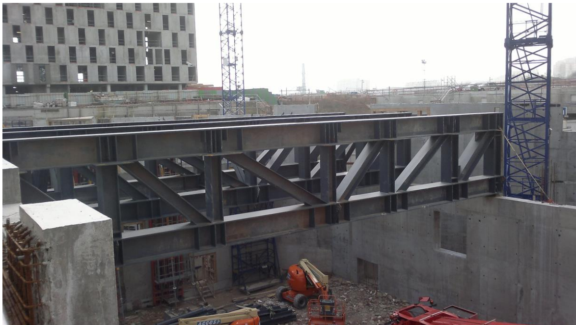
Φωτ. 5: Τοποθέτηση υπερ-δικτυωμάτων στο εργοτάξιο
