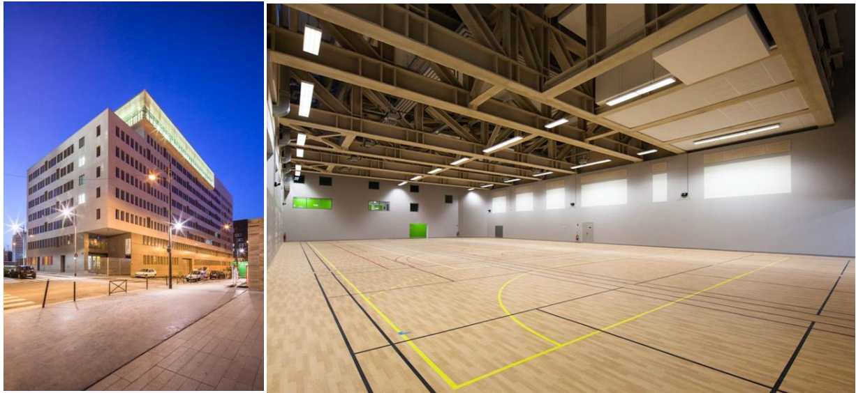
Φωτ. 4: Αίθουσα γυμναστηρίου κτιρίου M6A1 & υπερ-δικτυώματα έδρασης ανωδομής
