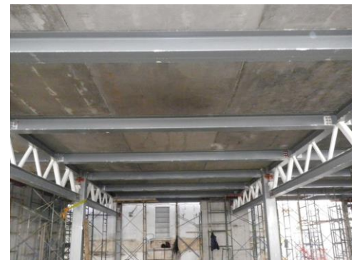
Φωτ. 8 – Φορέας οροφής ισογείου
