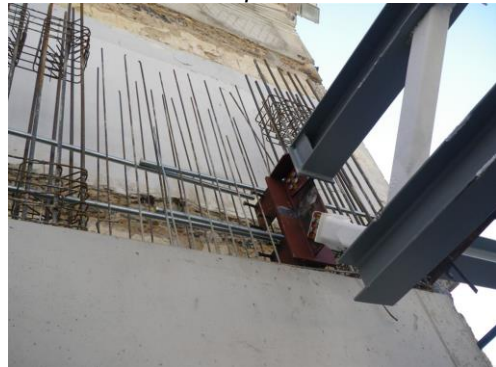
Φωτ. 6 Τοποθέτηση σύνδεσης διακτινώματος σε τοίχείο
