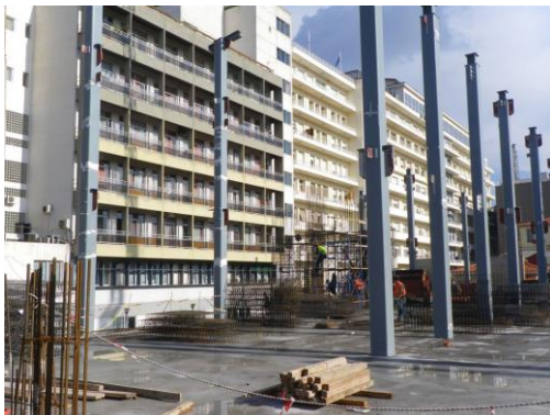
Φωτ. 7 – Ανεγερμένα υποστυλώματα
