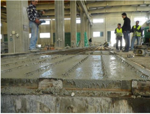
Φωτ. 3 – Διάστρωση σκυροδέματος προπλακών
