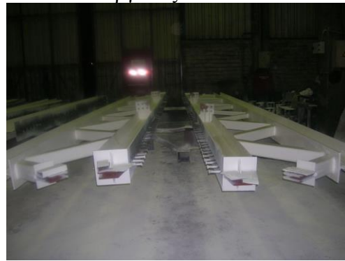
Φωτ. 2 – Πυροβαφή δικτυωμάτων στο εργοστάσιο
