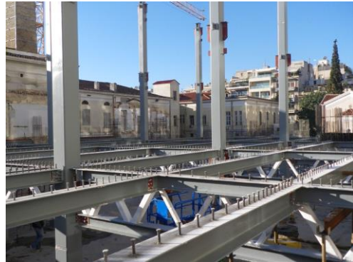
Φωτ. 4 – Ανέγερση μεταλλικού φορέα οροφής ισογείου
