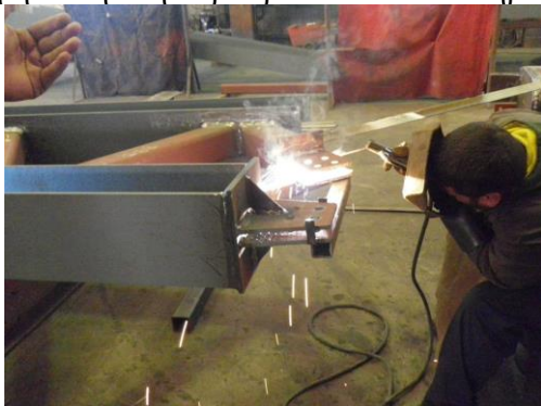
Φωτ. 1 – Εργοταξιακή συγκόλληση ελασμάτων δικτυώματος
