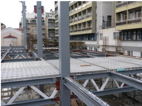
Φωτ. 5 – Τοποθέτηση προπλακών
