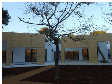
Σχ. 13 Αποπερατωμένο κτίριο νηπιαγωγείου
