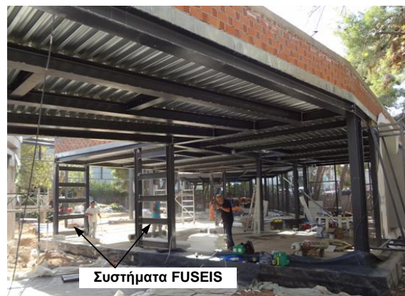
Σχ. 6 Εφαρμογή συστημάτων FUSEIS στο κτίριο
