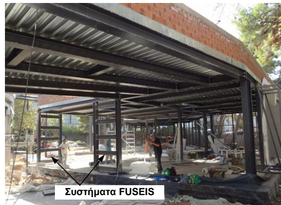
Σχ. 6 Εφαρμογή συστημάτων FUSEIS στο κτίριο
