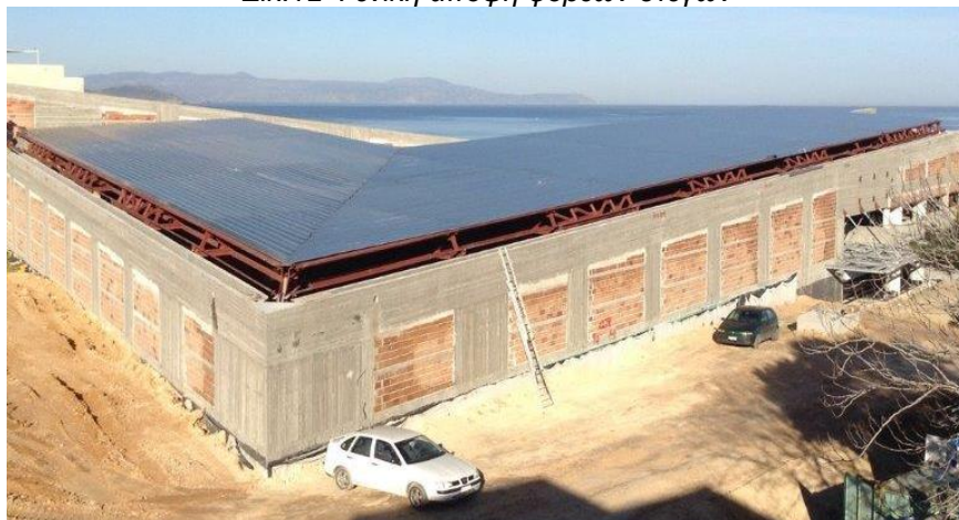
Εικ.13–Γενική άποψη φορέα στέγης με επικάλυψη
