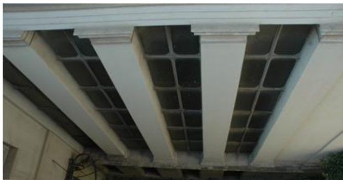
Εικ. 2 Κτήριο Β – κατακόρυφα φέροντα στοιχεία
