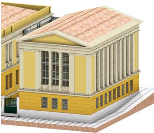
Εικ. 4 Κτίριο B – Οδός Ανθήμων Γαζή
