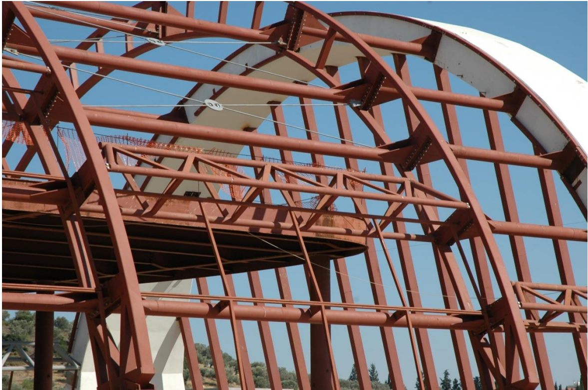
Εικ. 8 Λεπτομέρεια τριγωνικών τόξων καταλλήλων δια την αναπτυσσόμενη εις αυτά κάμψη από τις εφελκυστικές δυνάμεις αγκύρωσης των μεμβρανών
