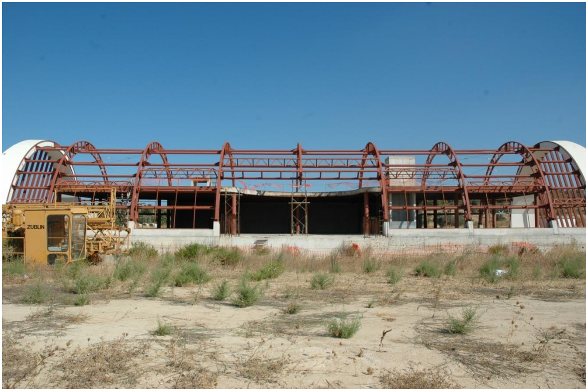
Εικ. 7 Εποπτική φωτογραφία μεταλλικού φορέα και τόξων περάτων από οπλισμένο σκυρόδεμα
