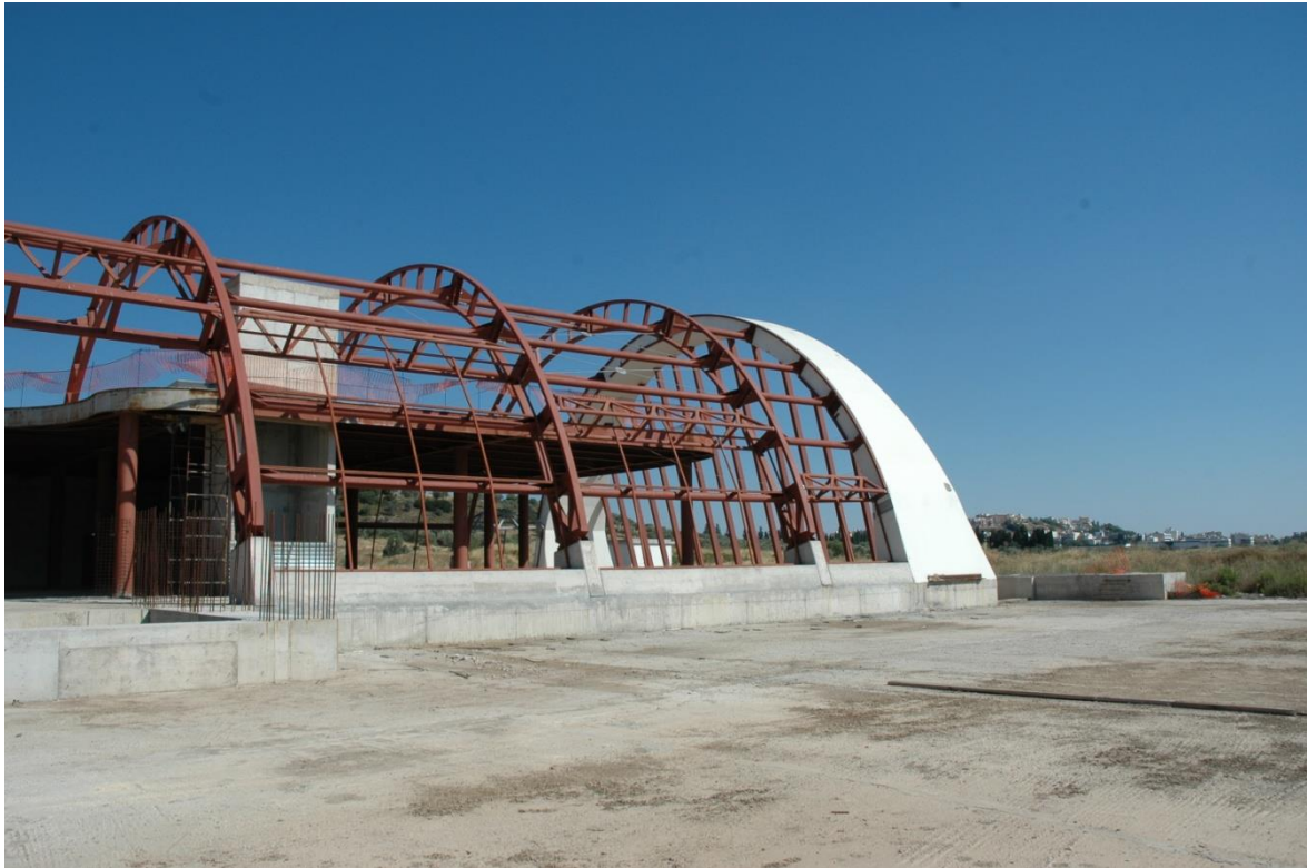
Εικ. 10 Ο μεταλλικός φορέας και το τόξο πέρατος από οπλισμένο σκυρόδεμα
