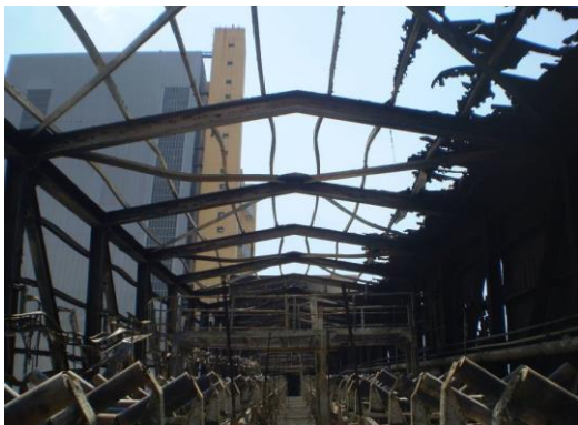
Σχ. 5 Βλάβες στις τειγίδες και στις οριζόντιες διαγώνιες ράβδους
