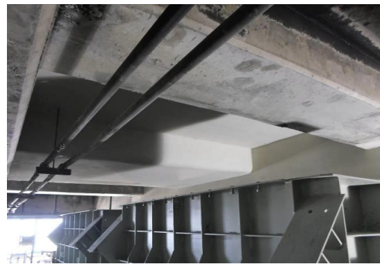
Σχ. 17. Άποψη πλάκας του κτιρίου bunker μετά την αποκατάσταση
