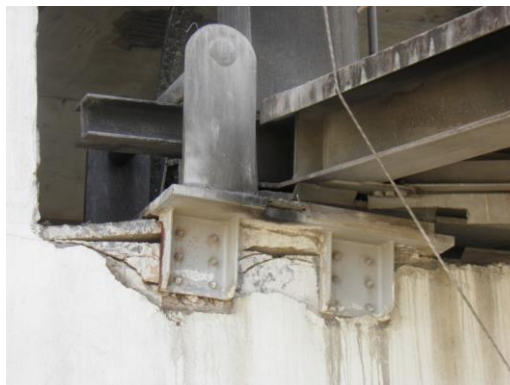
Σχ. 7 Ανασήκωμα της φέρουσας κατασκευής στην έδραση της στο κτίριο Bunker
