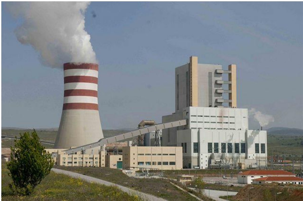
Σχ. 1. Γενική άποψη του εργοστασίου Μελίτη στην οποία διακρίνεται η γέφυρα ταινιοδρόμου και το κτίριο Bunker.
