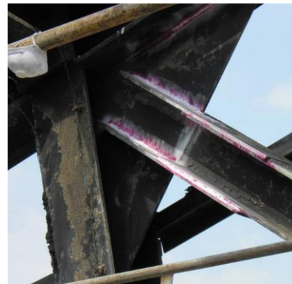
Σχ. 9 Έλεγχος συγκολλήσεων με δεισδυτικά υγρά
