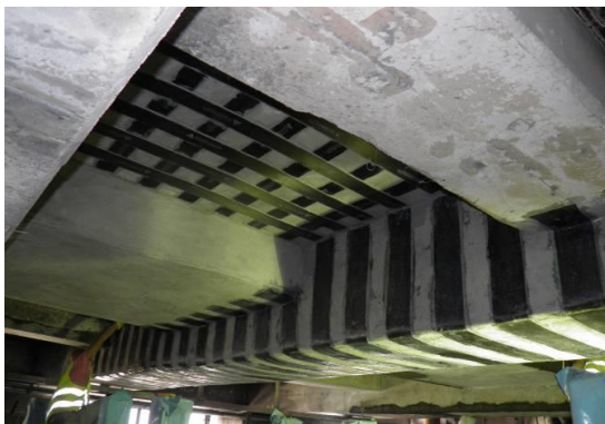
Σχ. 17. Άποψη πλάκας του κτιρίου bunker μετά την αποκατάσταση
