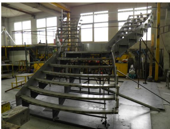
Σχ. 6(α). Άποψη από τη φάση της προκατασκευής.
