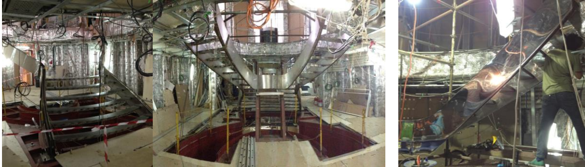
Σχ. 7. Απόψεις στη φάση κατασκευής..
