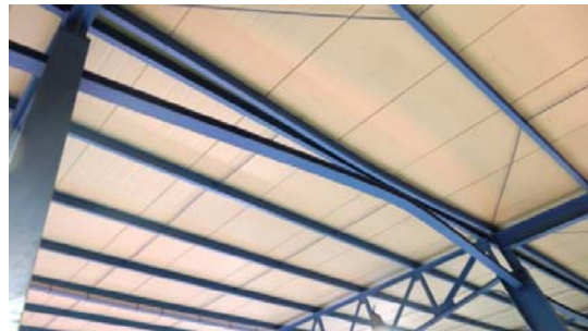
Εικ. 4: Μεταλλικά στοιχεία με σημαντικές παραμορφώσεις 2ας τάξεως.
