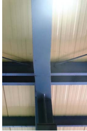
Εικ. 3: Ανεπαρκής σύνδεση δοκού-υπ/τος.
