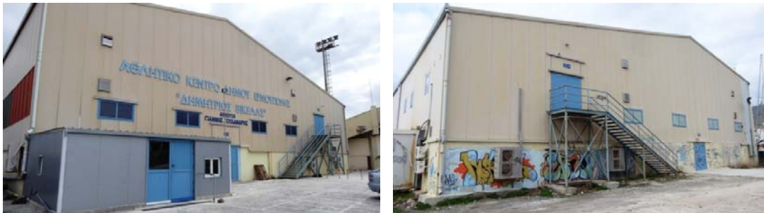
Εικ. 1: Γενικές όψεις του κτηρίου (αριστερά η δυτική, δεξιά η ανατολική).
