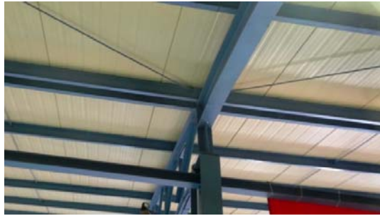
Εικ. 3: Ανεπαρκής σύνδεση δοκού-υπ/τος.
