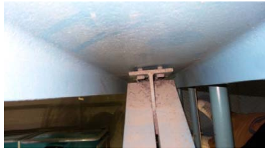
Εικ. 2: Σύνδεση με χαλαρή κοχλίωση.
