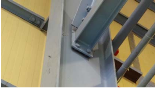
Εικ. 2: Σύνδεση με χαλαρή κοχλίωση.
