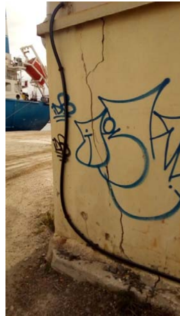
Εικ. 7: (α) Βάση υπ/τος με σημαντική οξείδωση και (β) τοιχείο πλινθοδομής με έντονη ρηγματώση.
