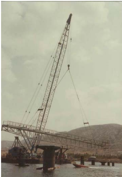
Φωτ.4: Η εγκατάσταση του πρώτου δικτυωτού γεφυρώματος το 1982
