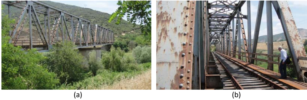
Φωτ. 1. Φωτογραφική αποτύπωση της γέφυρας Εχεδώρου α) εξωτερική άποψη, β) εσωτερική άποψη
