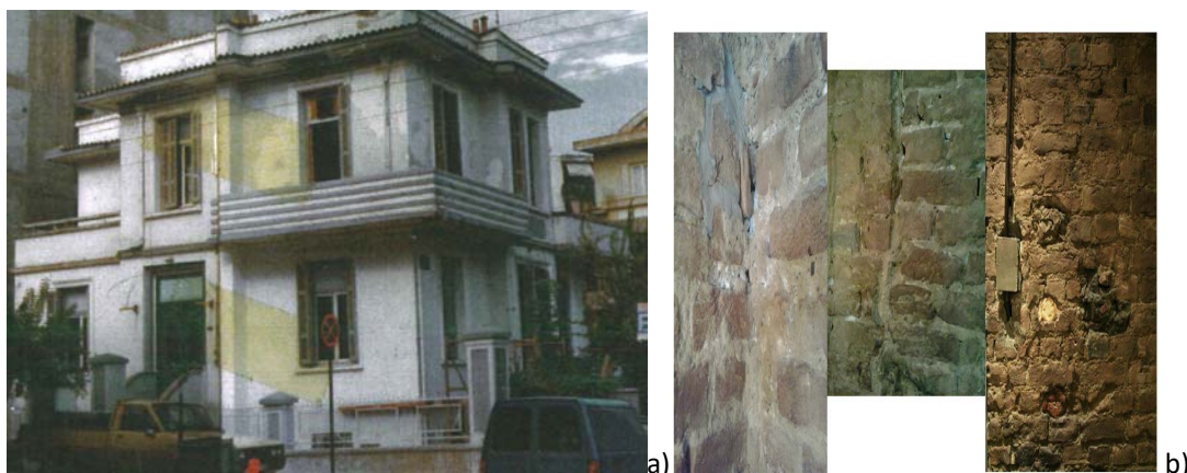
Φωτ. 1 a) Άποψη αρχικής μορφής διατηρητέου κτιρίου, b) Εσωτερική εικόνα (ισόγειο) φέρουσας τοιχοποιίας διατηρητέου κτιρίου.
