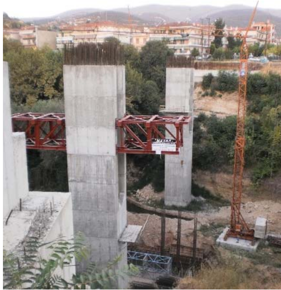
Φωτ. 1 Υφιστάμενα μεσόβαθρα με αναρτημένο χαλύβδινο δικτύωμα
