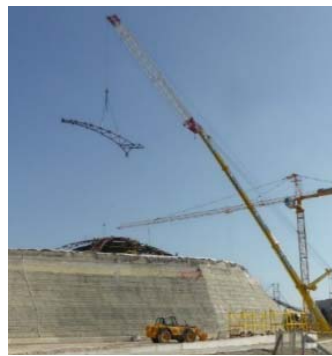
Φωτ. 24 - Ανύψωση επίπεδου δικτυώματος
