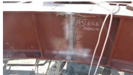
Φωτ. 7 – Εργοταξιακή εσωραφή δακτυλίου
