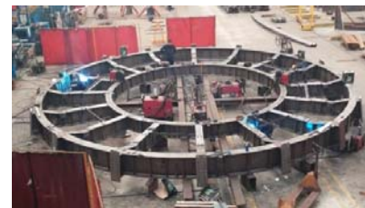
Φωτ. 16 - Προσυναρμολόγηση δακτυλίου
