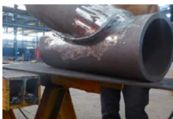
Φωτ. 25 - Branch joint W.P.Q.R. - Οπτικός έλεγχος μετά τη συγκόλληση
