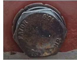
Φωτ. 20 - Κοχλίας μετά τον καθαρισμό
