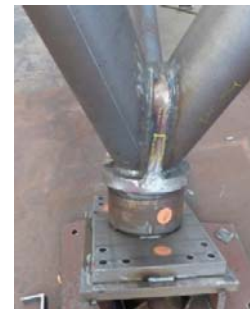
Φωτ. 5 - Έδραση τριγωνικών δικτυωμάτων
