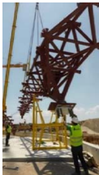
Φωτ. 23 - Ανύψωση τριγωνικού δικτυώματος
