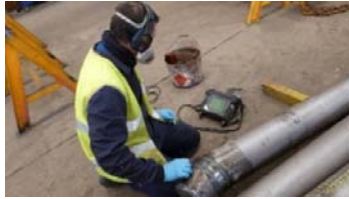
Φωτ. 27 - Έλεγχος με υπερήχους (UT)
