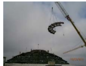
Φωτ. 22 - Ανύψωση 1/2 δακτυλίου
