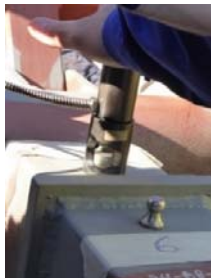
Φωτ. 31 - Έλεγχος πρόσφυσης σε επισκευή
