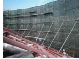
Φωτ. 18 - Περιμετρική κατασκευή προστασίας
