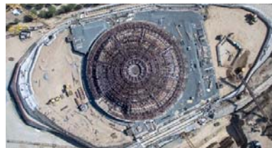
Φωτ. 2 – Ο Θόλος κατά την ανέγερση
