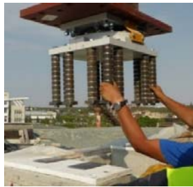
Φωτ. 9 - Έδραση δικτυωμάτων
