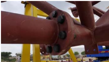
Φωτ. 8 - Αποκατάσταση συνέχειας
