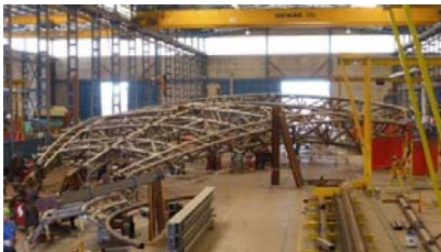
Φωτ. 15 - Προσυναρμολόγηση τμήματος φορέα
