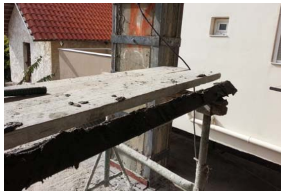
Φωτογραφία 5. Πλήρωση γωνιακού ελασματος με μη συρρικνούμενο κονίαμα υψηλής αντοχής πριν την τοποθέτησή του
