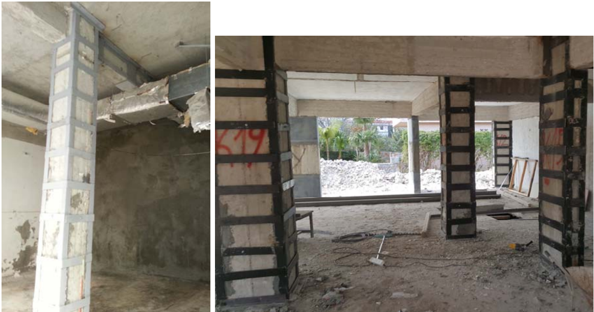
Φωτ. 1,2 εφαρμογή ενίσχυσης μεταλλικού κλωβού σε υποστυλώματα
