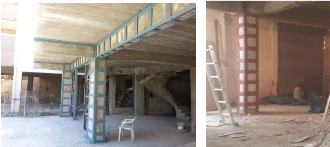
Φωτογραφία. 3,4 εφαρμογή ενίσχυσης μεταλλικού κλωβού σε υποστυλώματα και δοκούς
