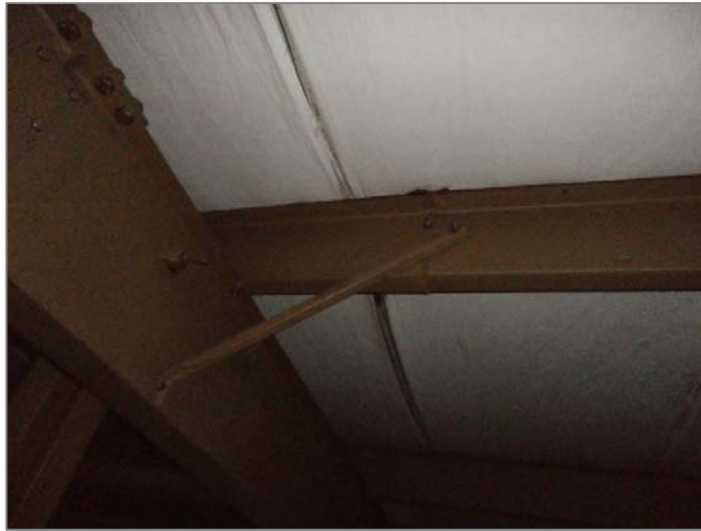
Φωτ. 5 Υφιστάμενες τεγίδες
