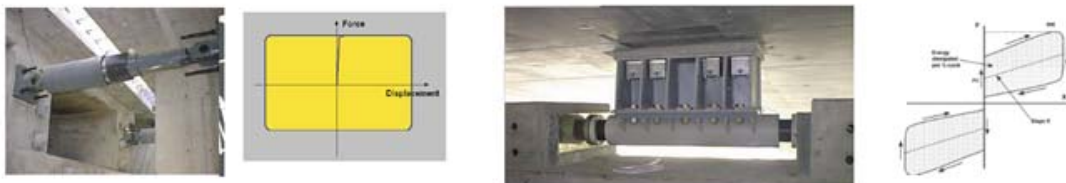
Σχ. 3: Υδραυλικοί αποσβεστήρες Τύπου A και τύπου B
