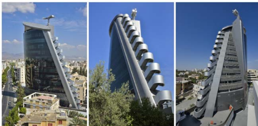
Φωτ. 1 - Προσόψεις κτιρίου
