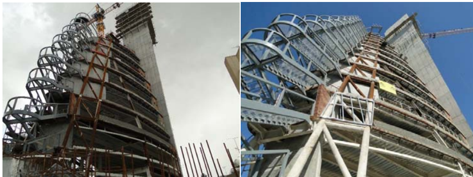
Φωτ. 6 - Κατασκευή εξωτερικού κλιμακοστασίου
