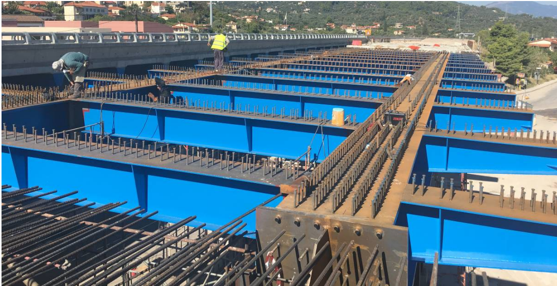
Σχ. 4: Άποψη του μεταλλικού τμήματος του φορέα
