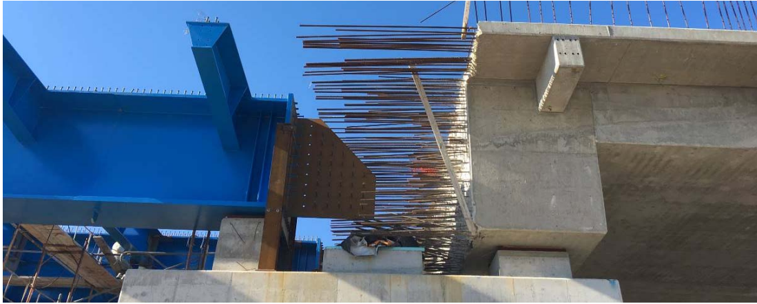
Σχ. 6: Περιοχή κόμβου σύνδεσης σύμμικτου ανοίγματος με τα ακραία ανοίγματα
