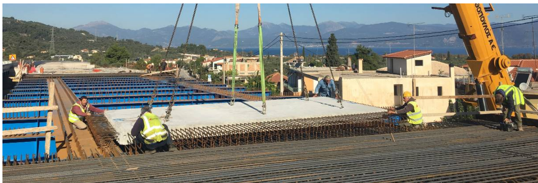
Σχ. 5: Τοποθέτηση προκατασκευασμένων πλακών οπλισμένου σκυροδέματος
