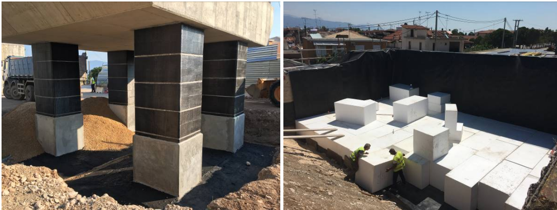
Σχ. 2: Αριστερά: ενίσχυση υποστυλωμάτων μεσοβάθρων με ινοπλισμένα πολυμερή (FRP), Δεξιά: τοποθέτηση τεμαχίων διογκωμένης πολυστερίνης (EPS) πίσω από τα ακρόβαθρα.
